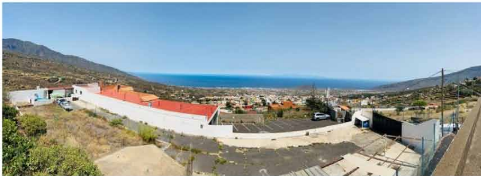
Vista desde el depósito de Majuelo del municipio de Arafo, camino de una semana sin agua potable.
