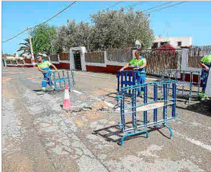
Operarios trabajando para arreglar la tubería. Foto: M. COPA
